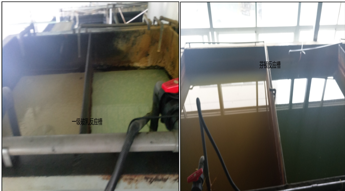
图 6：废拉丝液处理设施
