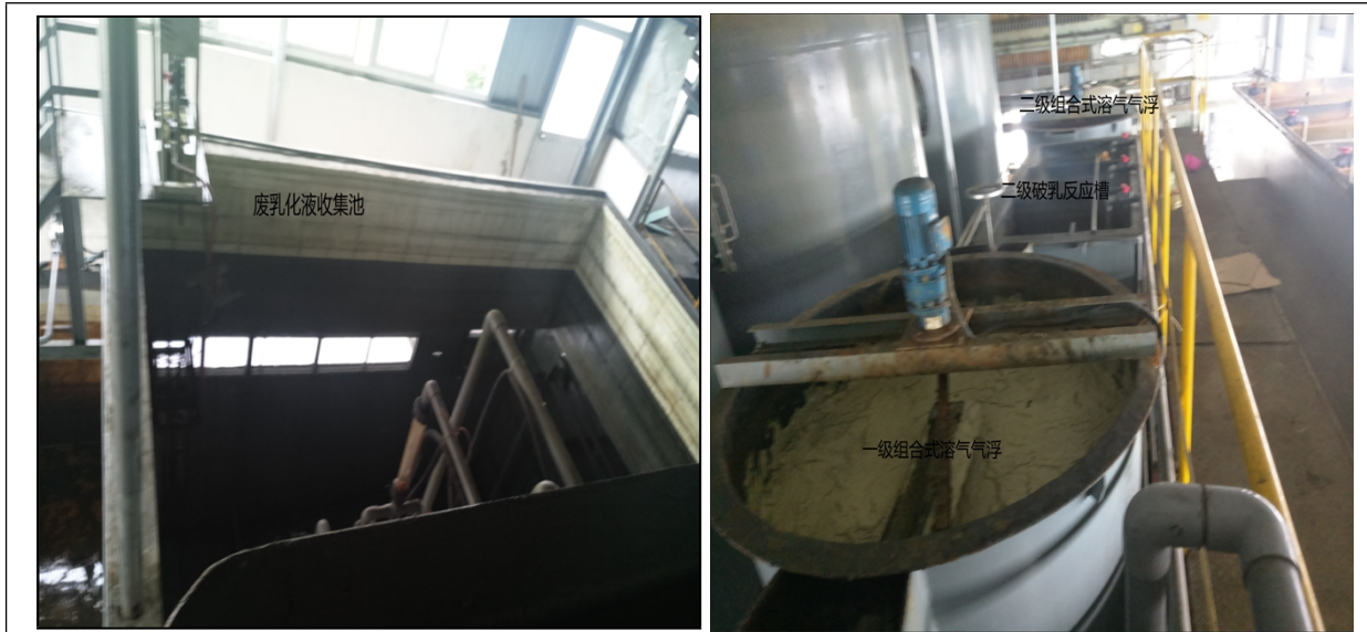
图 5：废拉丝液处理设施
