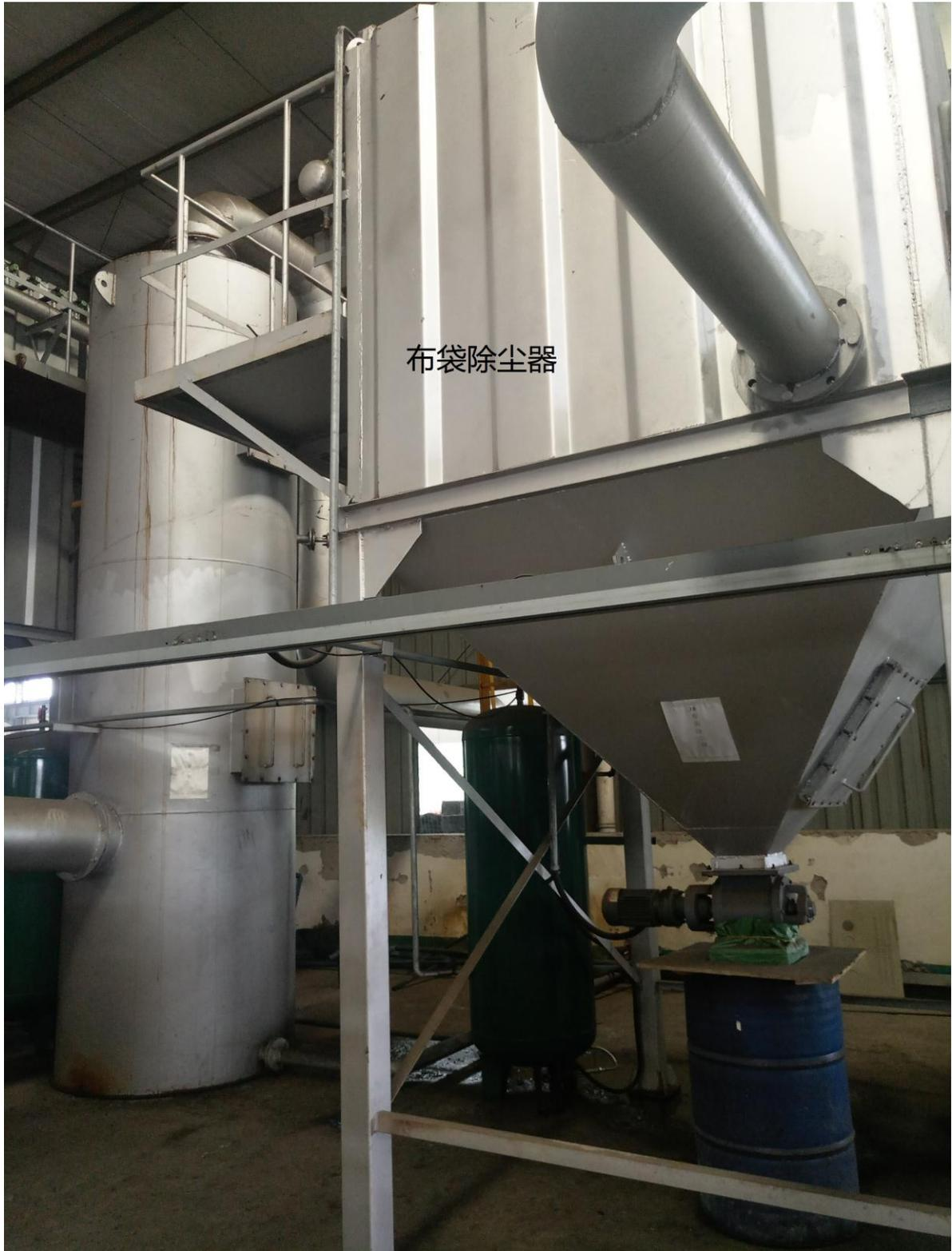
图 4.1-7 吹扫粉尘布袋除尘器
