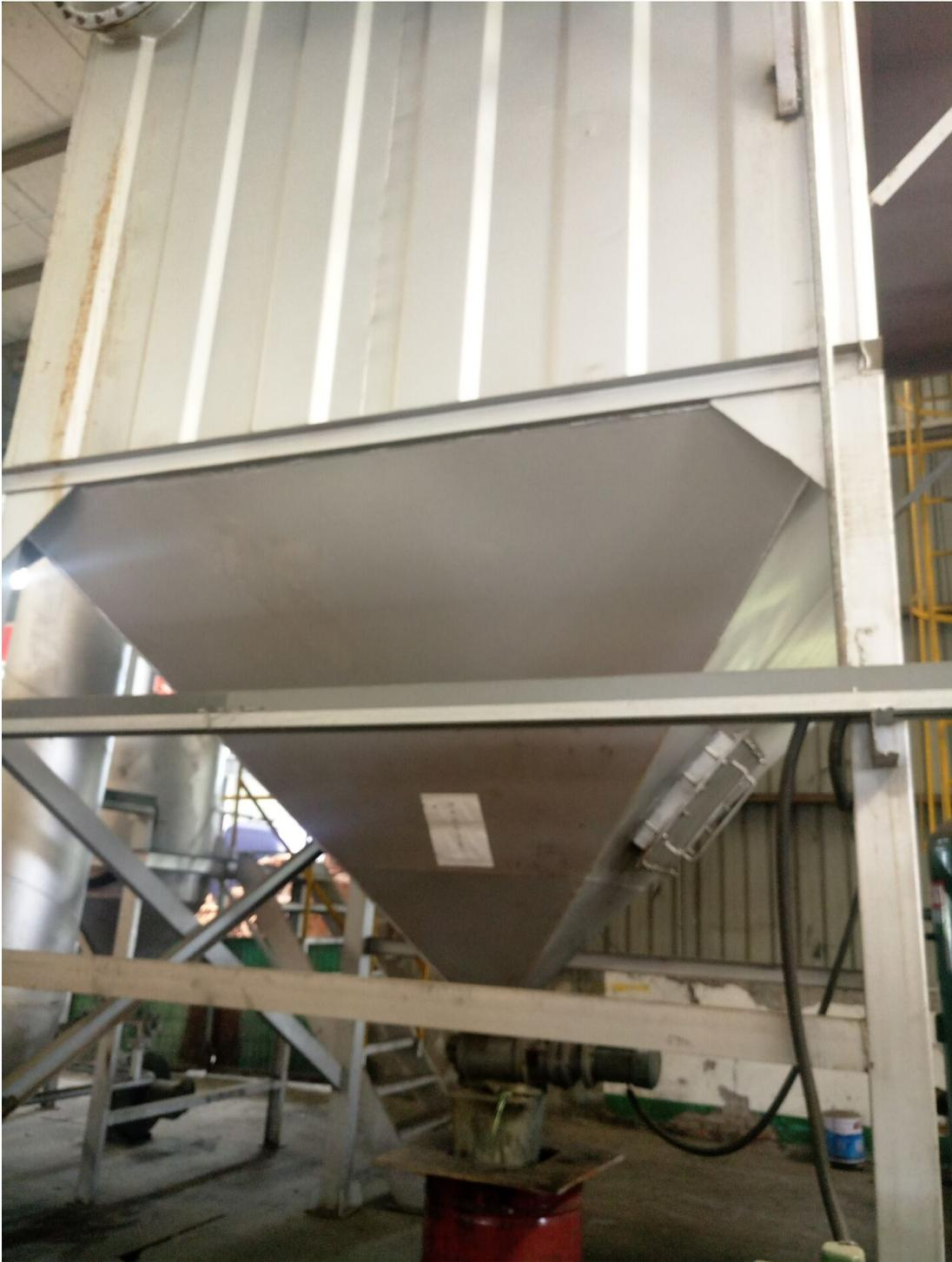
图 4.1-9 热解废气布袋除尘器
