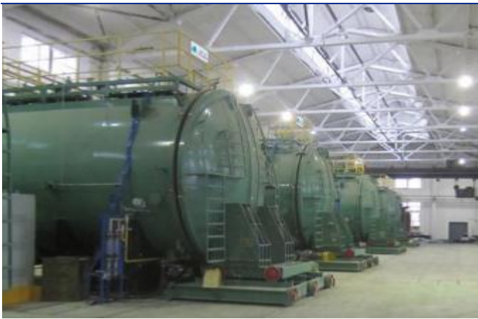
图 22：顶立科技真空碳化炉
